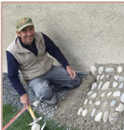
Les travaux d'assainissement des murs de l'église de la Sainte Trinité : réalisation d'un drain continu avec raccordement au réseau des eaux pluviales et finition par une "calade" réalisée avec galets et mortier à la chaux.
